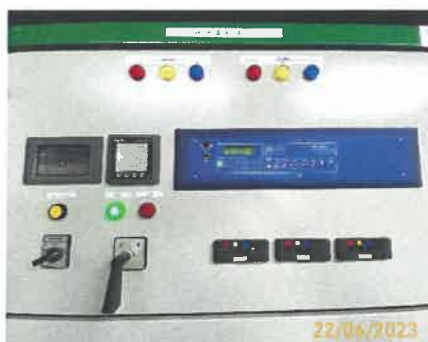
- อุปกรณ์ป้องกันแรงดันไฟฟ้าสูงเกิน -
