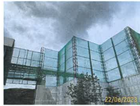
ภาพที่ 7 โครงเหล็กและตาข่ายโดยรอบ บริเวณพื้นที่ลานกองขานอ้อย
