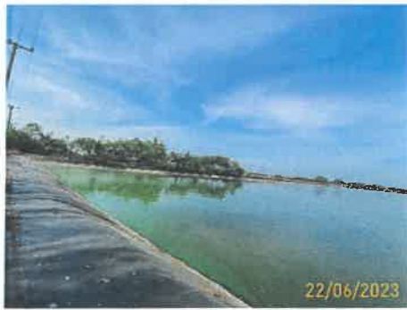
ภาพที่ 21 บ่อระบบบำบัดน้ำเสียแบบ Lining
