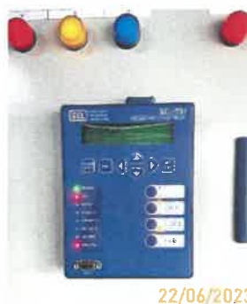
- อุปกรณ์ป้องกันกำลังไฟฟ้าไหลย้อนกลับ -
