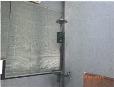
ภาพที่ 33 ฝักบัวและอ่างล้างตาฉุกเฉิน
