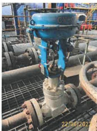
ภาพที่ 44 การติดตั้ง Control Valve
