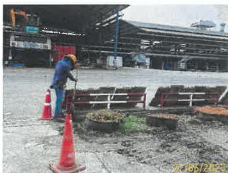
ภาพที่ 25 การขุดลอกรางระบายน้ำ
