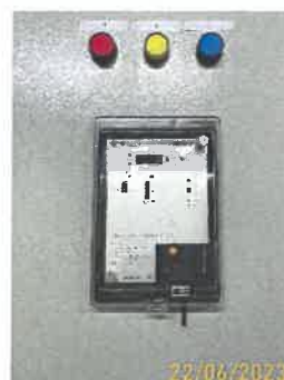
- อุปกรณ์ป้องกันการรั่วไหลของแรงดันไฟฟ้า -
