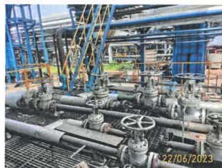
ภาพที่ 45 การติดตั้ง Bypass Valve
