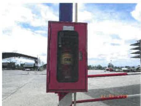
ภาพที่ 29 ถังดับเพลิงและป้ายแนะนำการใช้ถังดับเพลิง
